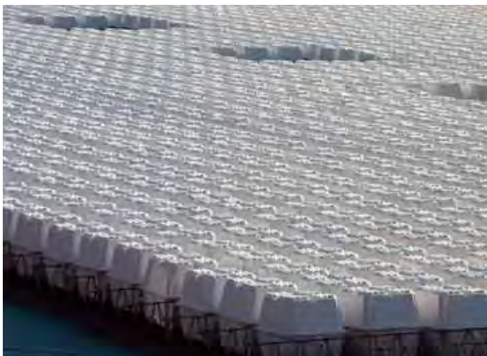
Příprava základové desky průmyslové haly
