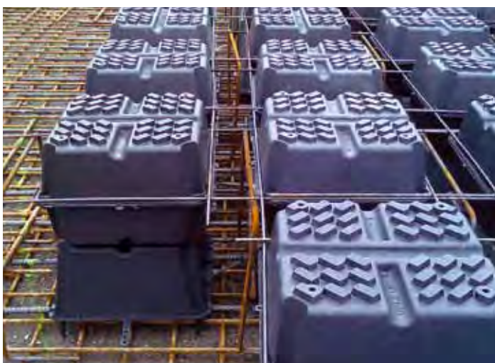
Příprava základové desky na nestabilním podloží
